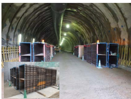
図-4 音響管を利用したトンネル発破時の低周波音低減（主に 16～20 Hz 帯域の発破音を吸音、低減） 6)
