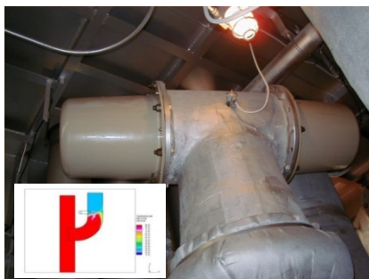
図-9 所内ボイラー煙突のANC
