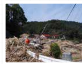
電柱の倒壊・管路の損壊
