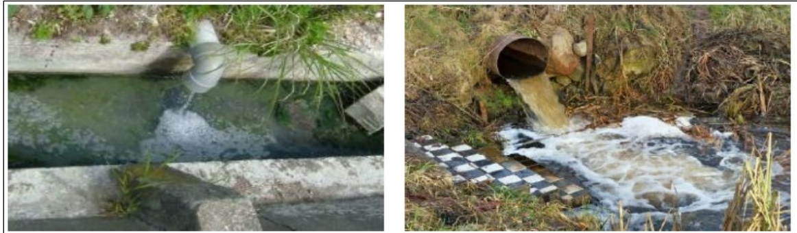
図 3 単独槽から生活雑排水が未処理のまま水路に流入している例
